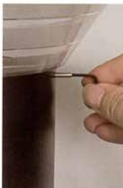
Utiliser la clé Allen pour serrer correctement les trois vis afin de fixer la tête du luminaire solaire sur le pilier.
